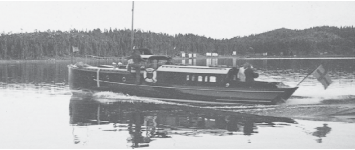
Motorbåtskryssaren "ASTRID", byggd 1936 för Dir. Pelle Hägglund Örns- köldsvik. Ömt vårdad och i originalskick redas "ASTRID" idag av sonen PG Hägglund. Något så ovanligt som en V-bottnad Petterssonbåt. Hade ursprungligen en Penta Hesselman på 40 hk, senare en 8 cyl Chrysler och numera en 96 hk Ford diesel. Foto från P.G. Hägglund.
