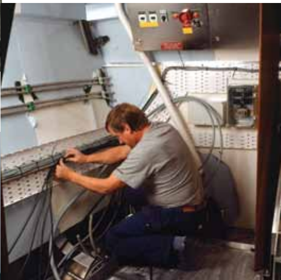
P-A Westin, Docksta Elteknik drar kabel.
